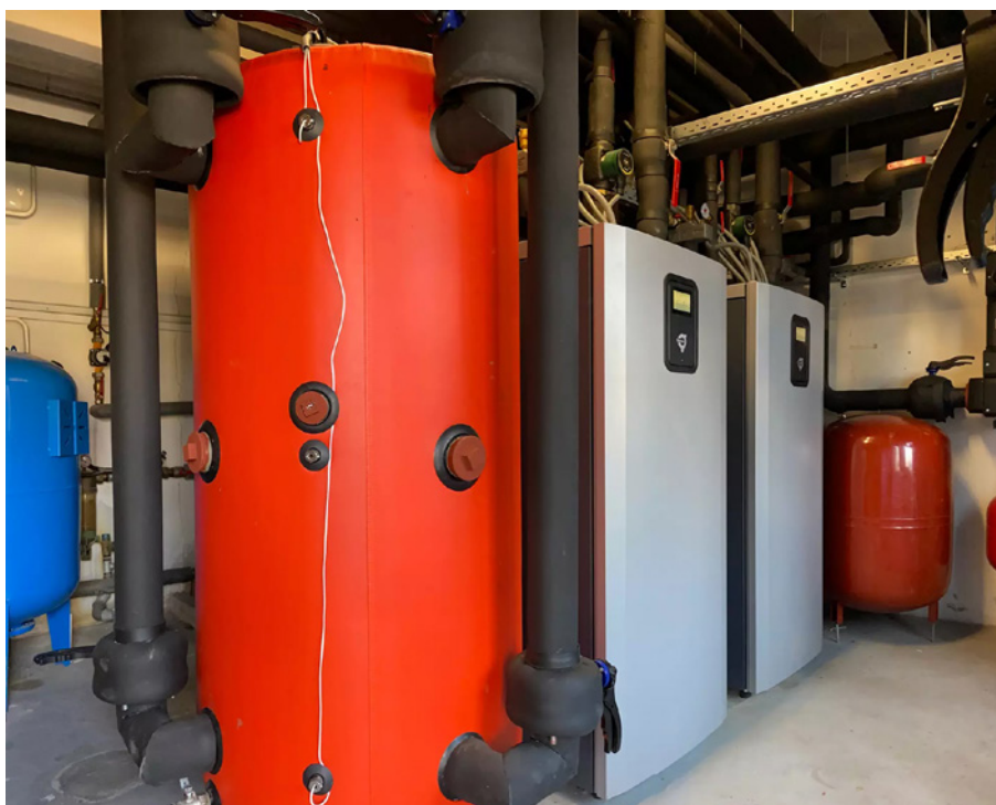
Tepelné čerpadlá Mega s buffer tankom
