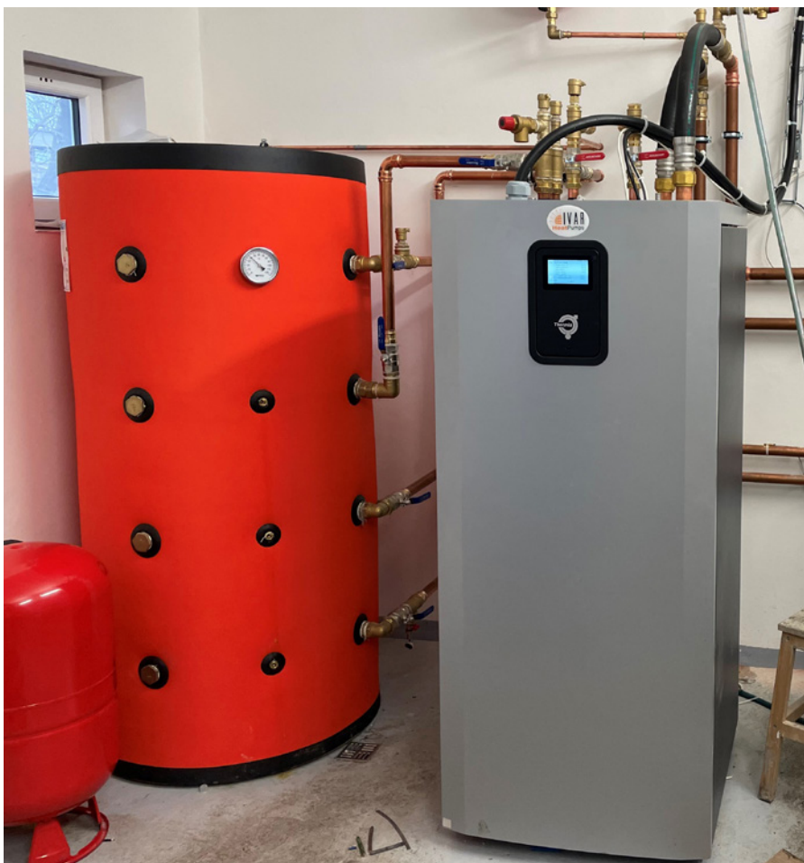
Tepelné čerpadlo typu zem/voda (voda/voda) Thermia Mega S
